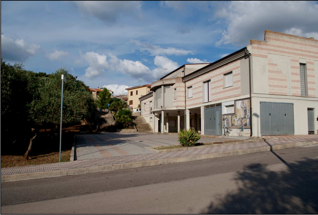
Foto 2: Centro Operativo Comunale - Retro
