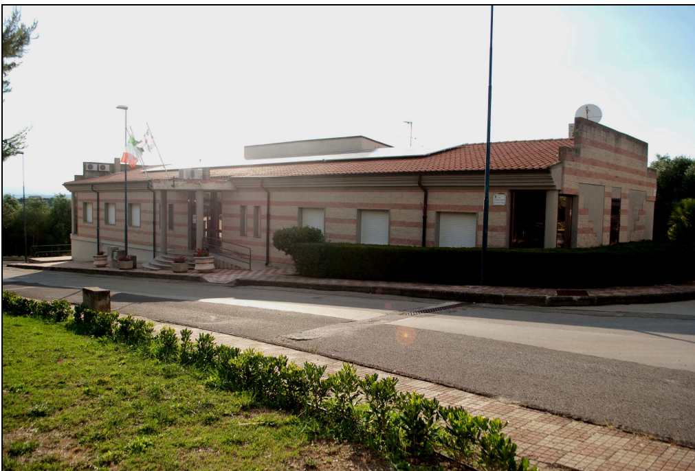
Foto 1: Centro Operativo Comunale – Vista frontale
