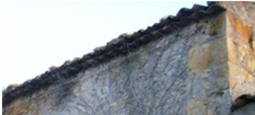
coppi canale sporgenti su un ulteriore aggetto di tegole rovesciate con smaltimento diretto delle acque
